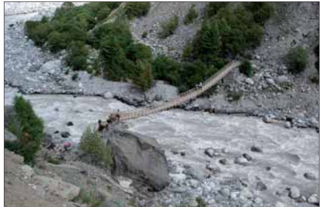
Attraversamento di un fiume, i cavalli portano il carico.
