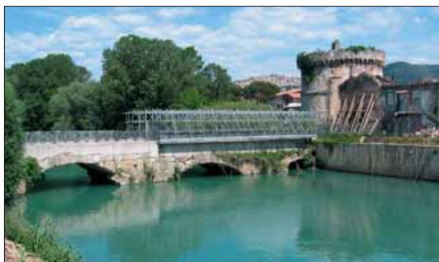
Vista d'insieme di Ponte Lucano con i nuovi parapetti metallici e la struttura temporanea realizzata per il montaggio e la verniciatura della ringhiera metallica.
