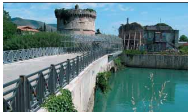
Un'immagine ravvicinata che consente di vedere i particolari della ringhiera metallica costruita sul ponte.
