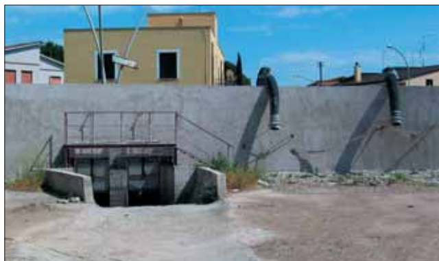
Le saracinesche realizzate sotto il muro di Ponte Lucano per lo scarico delle acque piovane e i tubi di scarico delle idrovore.
