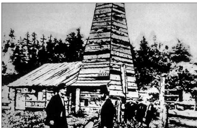
Primo giacimento di petrolio perforato; aveva una profondità di 21 metri. Da esso fu possibile estrarre 2.500 Kg di petrolio al giorno.
