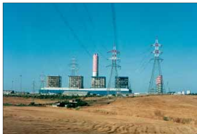
Centrale termoelettrica di Montalto di Castro in produzione dal 1995.
