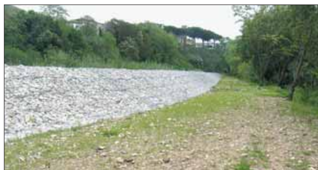
L'argine costruito sulla sponda destra del bacino San Giovanni a Tivoli.
