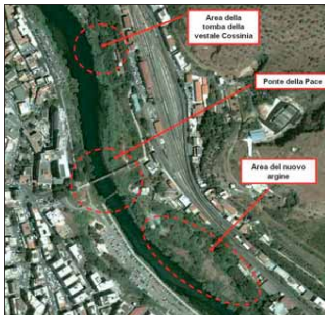
Ripresa aerea della zona del bacino San Giovanni. Sono evidenziati alcuni punti di interesse.
