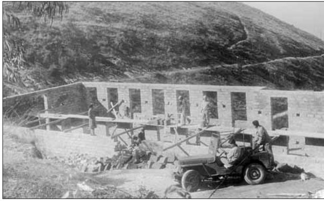
Particolare della costruzione del secondo piano (foto tratta dal libro "Quando i sogni si avverano" di D. Giubilei, vol. 1, pag. 223, Tivoli 2004).
