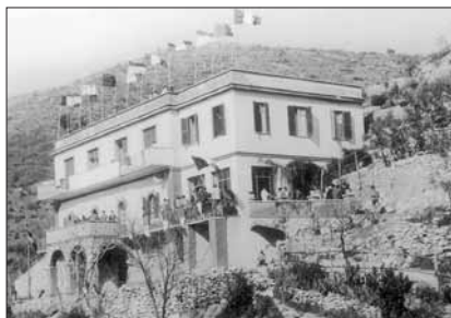
La struttura al termine della prima fase dei lavori (foto tratta dal libro "Quando i sogni si avverano" di D. Giubilei, vol. 1, pag. 221, Tivoli 2004).
