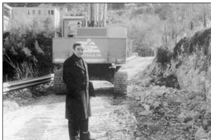
I lavori della strada
