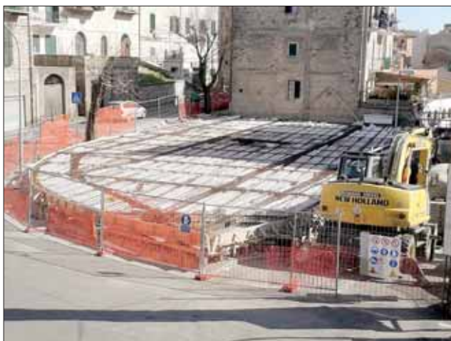
Durante i lavori
