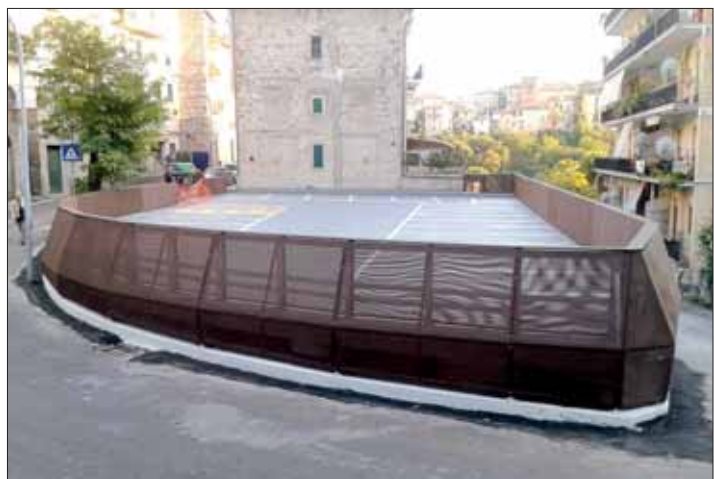
A lavori ultimati
