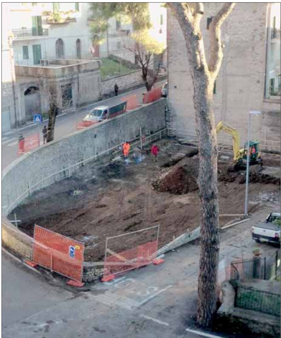
Prima dei lavori
