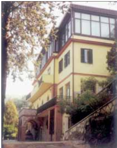
I lavori e le diverse fasi edilizie
