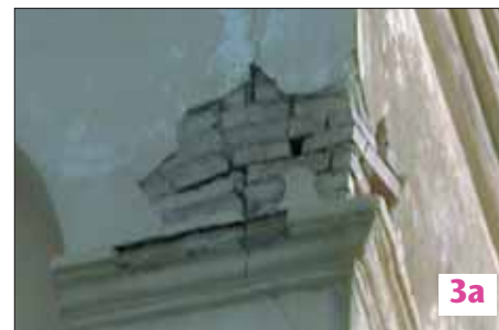
Campanile lesionato: particolare del danno visto dalla strada
