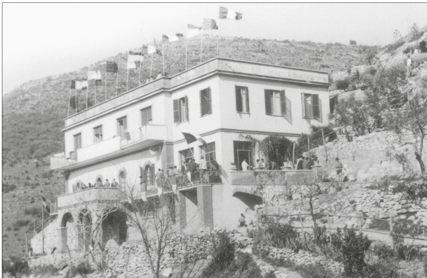
La struttura al termine della prima fase dei lavori
