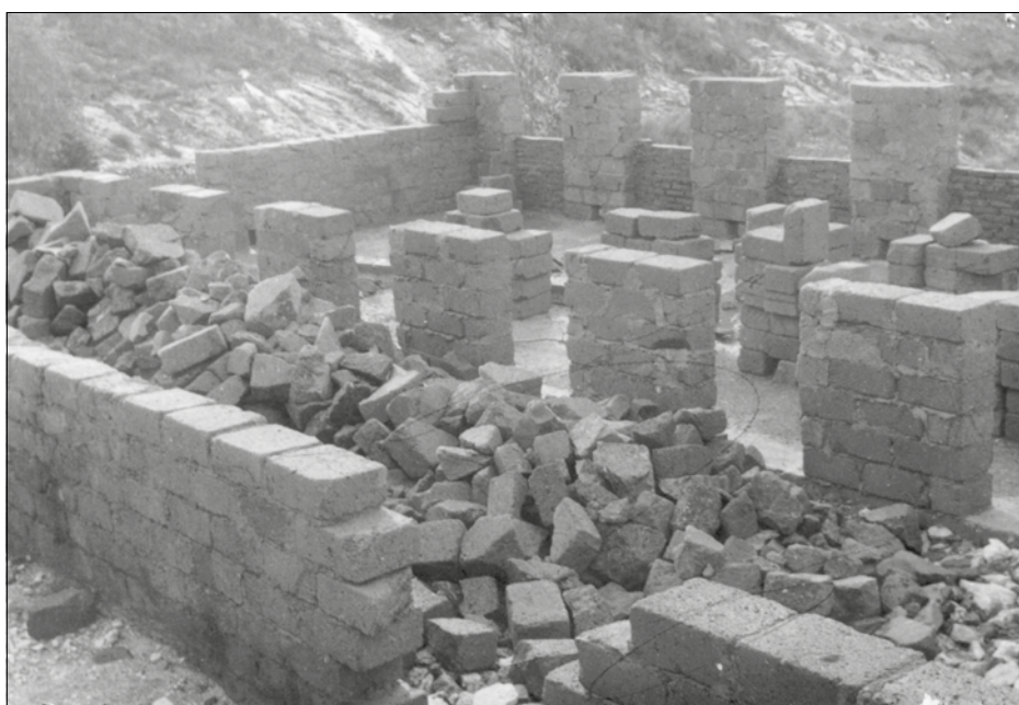
Il secondo piano in costruzione
