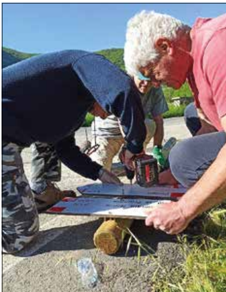
Installazione segnaletica verticale Sentiero Italia CAI
