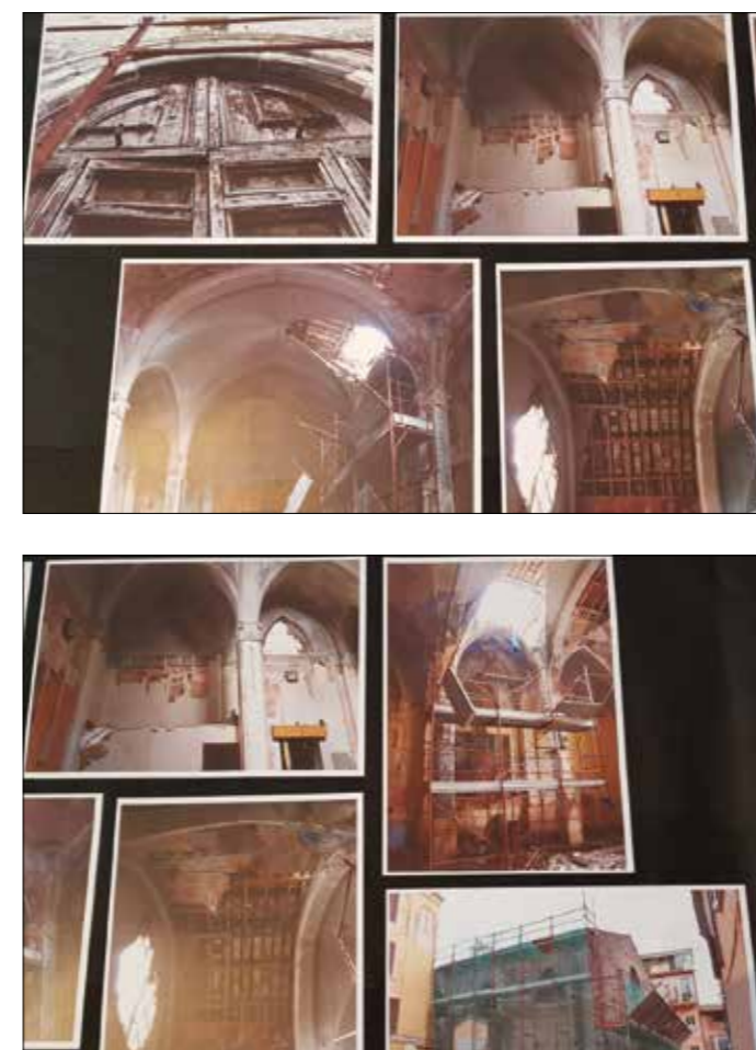
Con i lavori, iniziati nel 2019, si è proceduto al completo rifacimento del tetto, al rinforzo delle pareti esterne, alla ricostruzione di una volta a crociera crollata all'interno, al ripristino dell'impianto elettrico e al restauro di un affresco raffigurante Santa Sinfiorosa e della pala d'altare in parte riscoperta dietro un muro in mattoncini.
