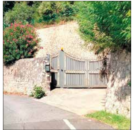
Attuale ingresso dell'antica strada
